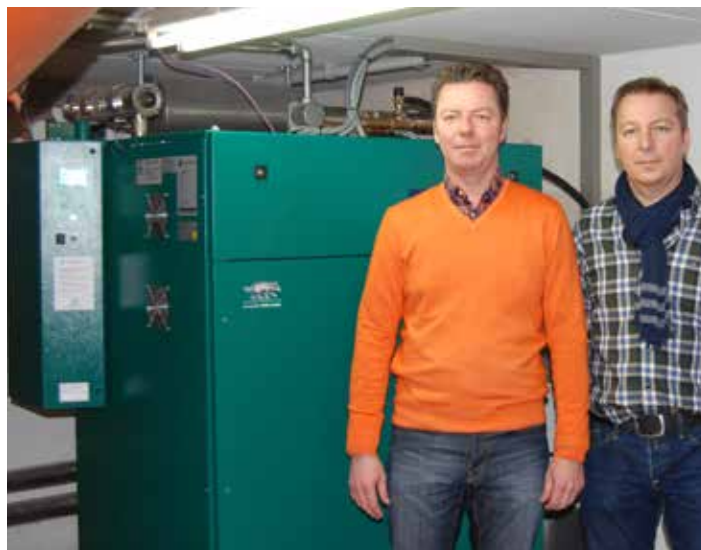
GUNTHER (LINKS) UND JOCHEN KRINES FREUEN SICH ÜBER DEN DACHS PRO 20 ST IN IHREM HEIZUNGSKELLER.
