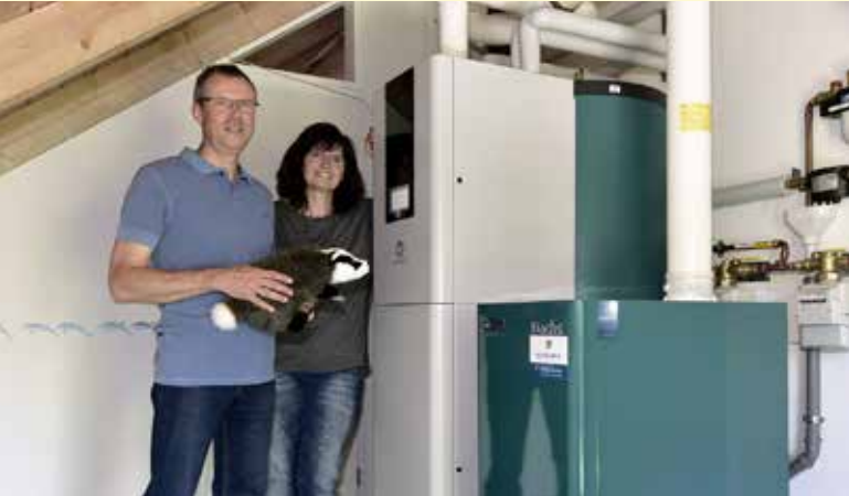
Von wegen ab in den Keller: Der kompakte Dachs InnoGen findet überall Platz – bei Familie Dilger steht er im Dachgeschoss.
